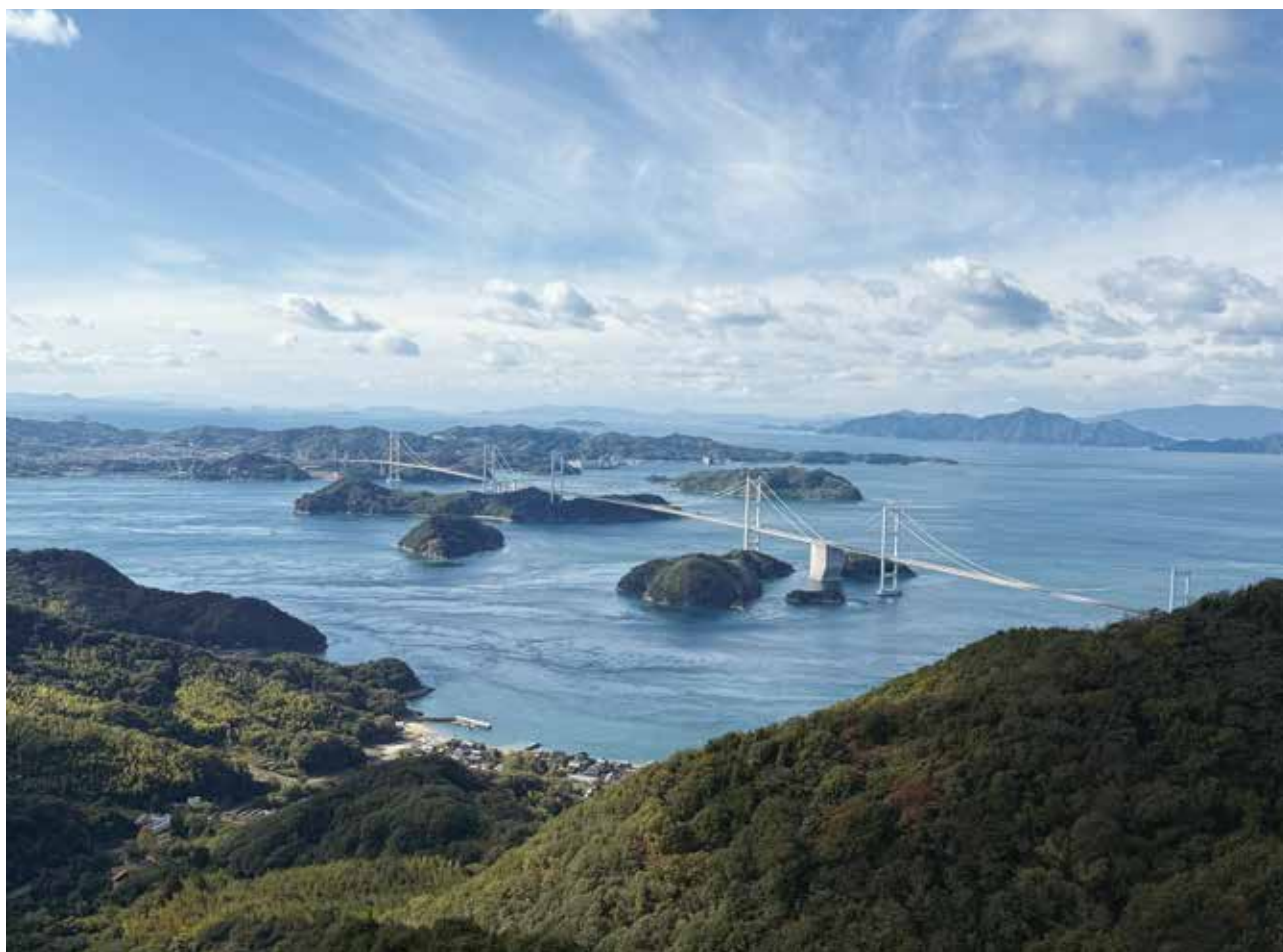
来島海峡大橋
