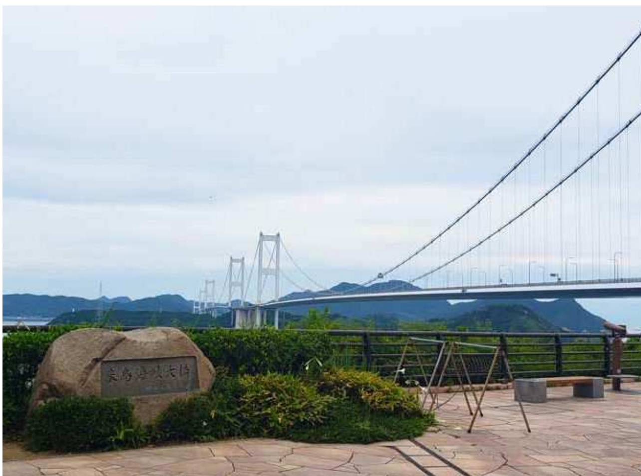
来島海峡大橋
