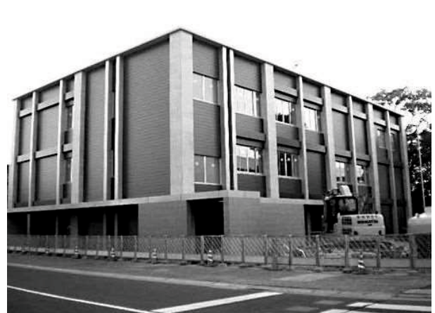
写真6 丸亀署の新築工事風景(令和2年8月撮影) 現在地から北東の消防署跡地に建築しています。
